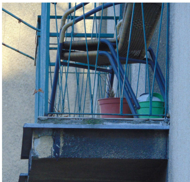
kotvení zábradlí u balkónu typu „b“ (shora přes dlažbu + stěna)
