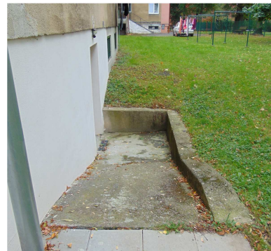
stav povrchů venkovní betonové rampy a navazujících svislých konstrukcí-rampa do 1.PP č.p.786
