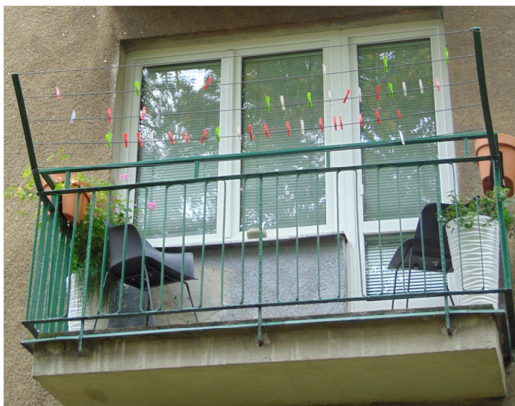
balkón typu „a“ (2500/750 mm) + způsob kotvení zábradlí (čelo balkón.desky, stěna)
