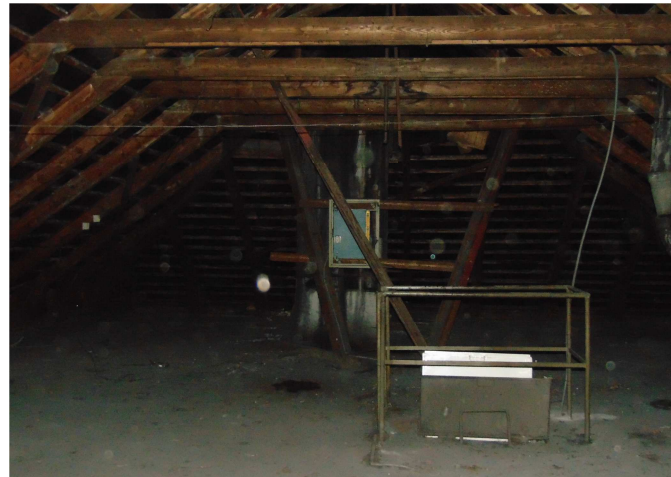
lepený vazníkový krov s laťováním
