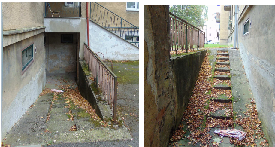
stav povrchů venkovní betonové rampy a navazujících svislých konstrukcí-rampa do 1.PP č.p.553
